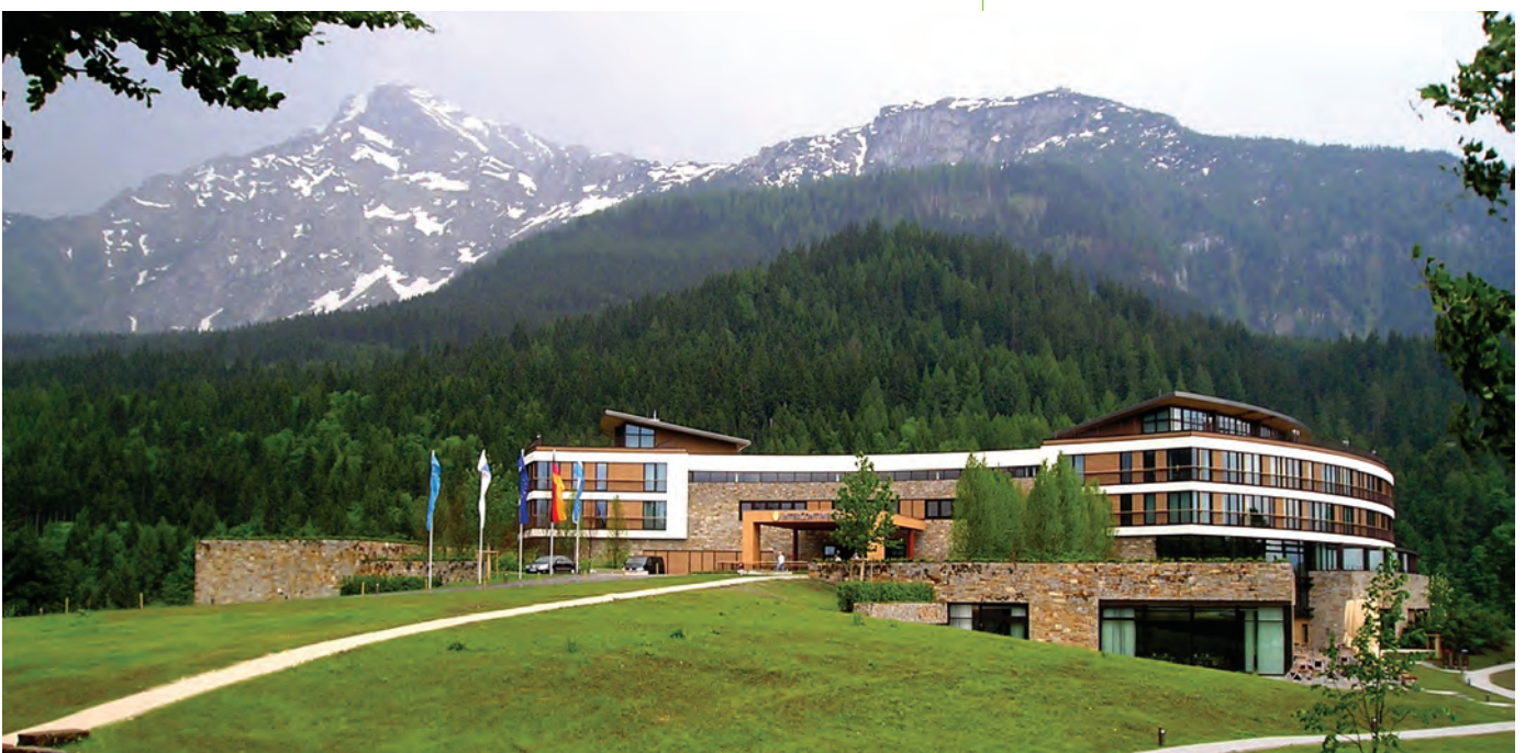
Beim Neubau von Infrastruktur, wie Hotelanlagen, sind vielfach auch die Belange von Natura 2000 zu beachten. U. Pröbstl
